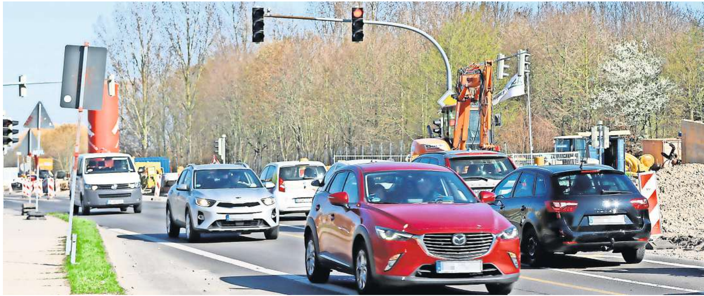
Auf der viel befahrenen Koitenhäger Landstraße müssen Autofahrer wegen der Bauarbeiten weiterhin mit Einschränkungen rechnen.
